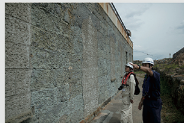
【写真③】コンクリートで埋められた跡跡(写真④)右側埋められたモルタル仕上げ。
