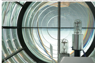
4. 灯台ライトルームの様子。5. レンズ内の照明装置。メタルハライドランプという特殊電球。
