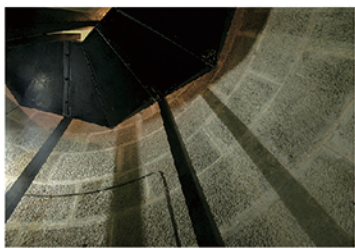
【写真①】灯台内部の構造。写真②は伊豆石の独特の質感が美しい。
